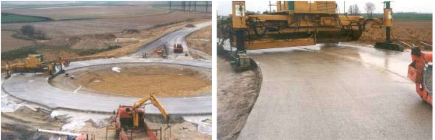
Figura 9: Esempio di realizzazione con tecnica Slipform.
