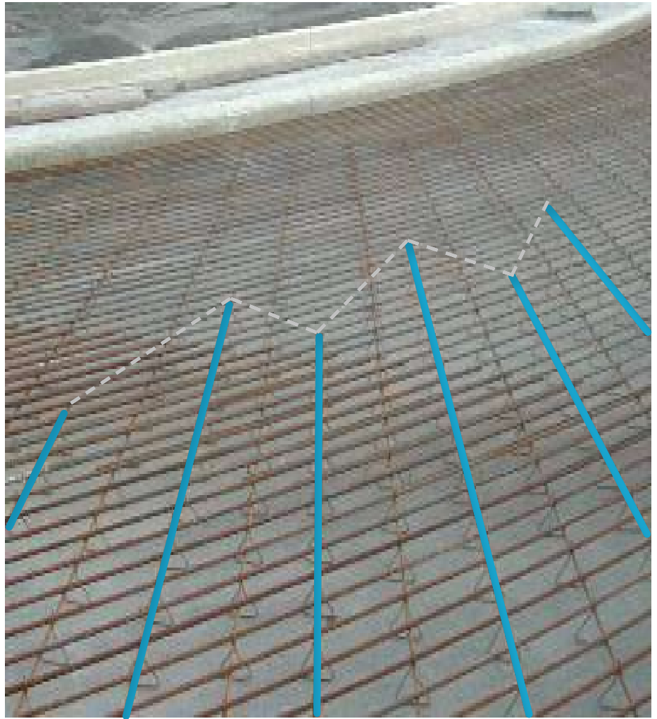
Figura 16: Disposizione delle armature trasversali nella semicorona esterna nel caso di rotonde con più di 20 m di diametro.
