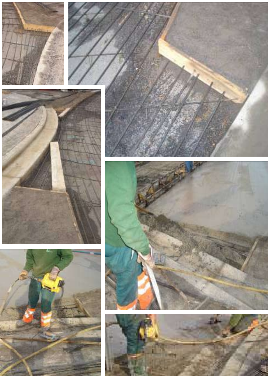
Figura 18: Lavorazioni nelle zone di innesto dei bracci di ingresso e uscita.
